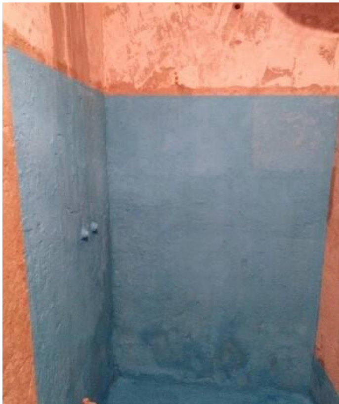
第三步：闭水试验
